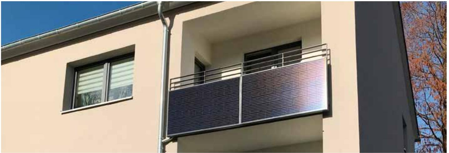
Irgendwann ist immer das erste Mal – vor allem wenn es um neue Technologien geht. Deshalb haben wir bei der Balkonsanierung an der Otto-Hue-Straße 26–30d etwas Neues ausprobiert: In die neu errichteten Brüstungen sind kleine Photovoltaikanlagen fest eingebaut worden. Immerhin 72 Module
