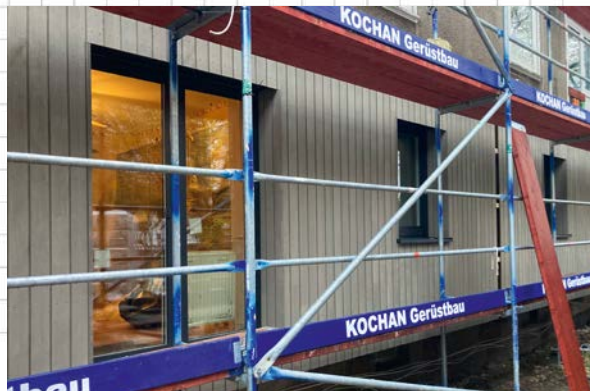
Anlieferung und Installation der ersten Fassadenelemente in der Goethestraße
