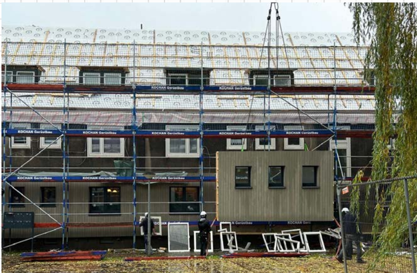
Anlieferung und Installation der ersten Fassadenelemente in der Goethestraße
